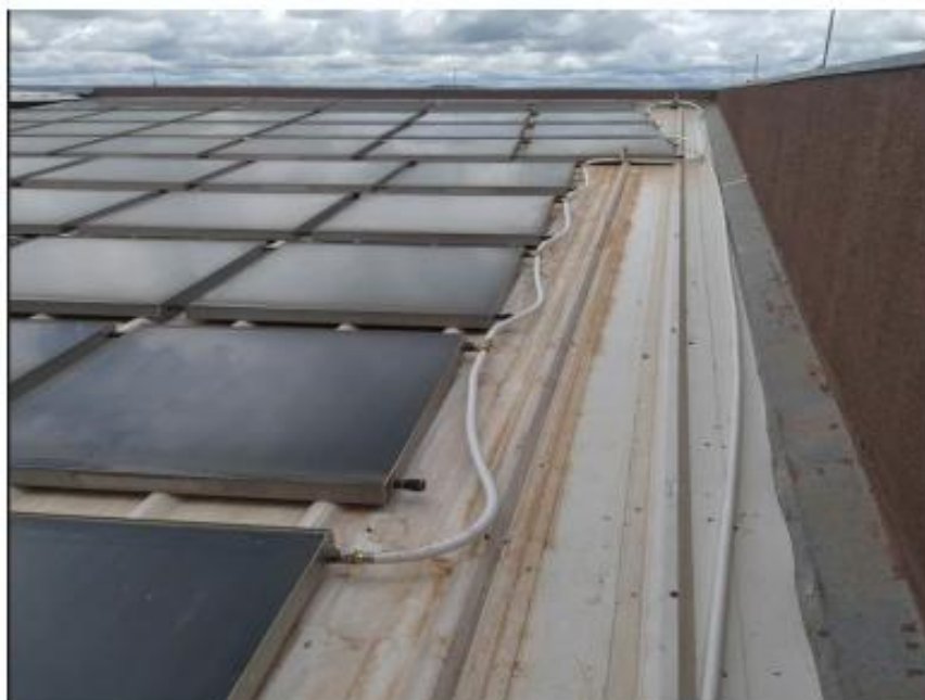
Figura 4: Nova tubulação em PEX, instalada.
