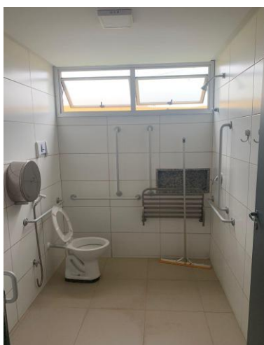
Figura 8 - Banheiro no pavimento térreo.
