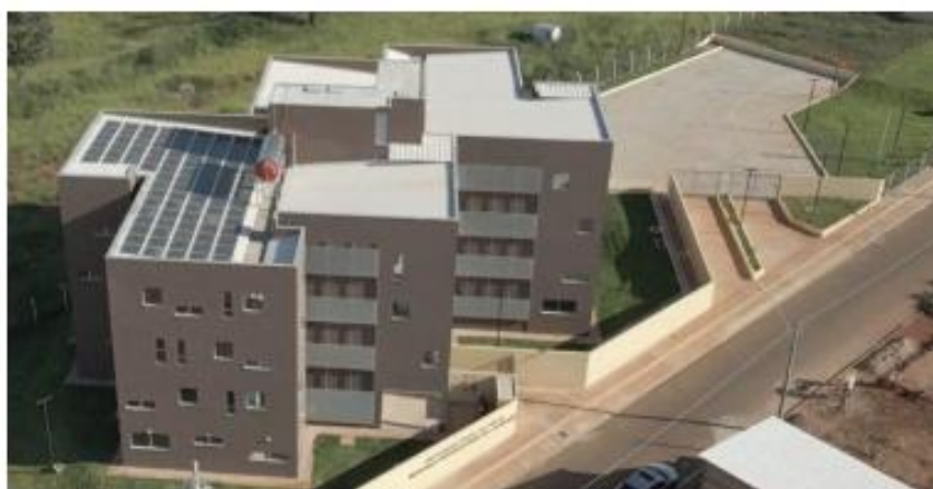
Figura 1: Fachada da Moradia Universitária do Cerrado (UFCAT).
